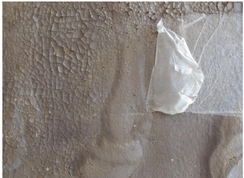
idem, detail (geel), opstaande verf schollen zijn gevlakt mbv Japans papier
